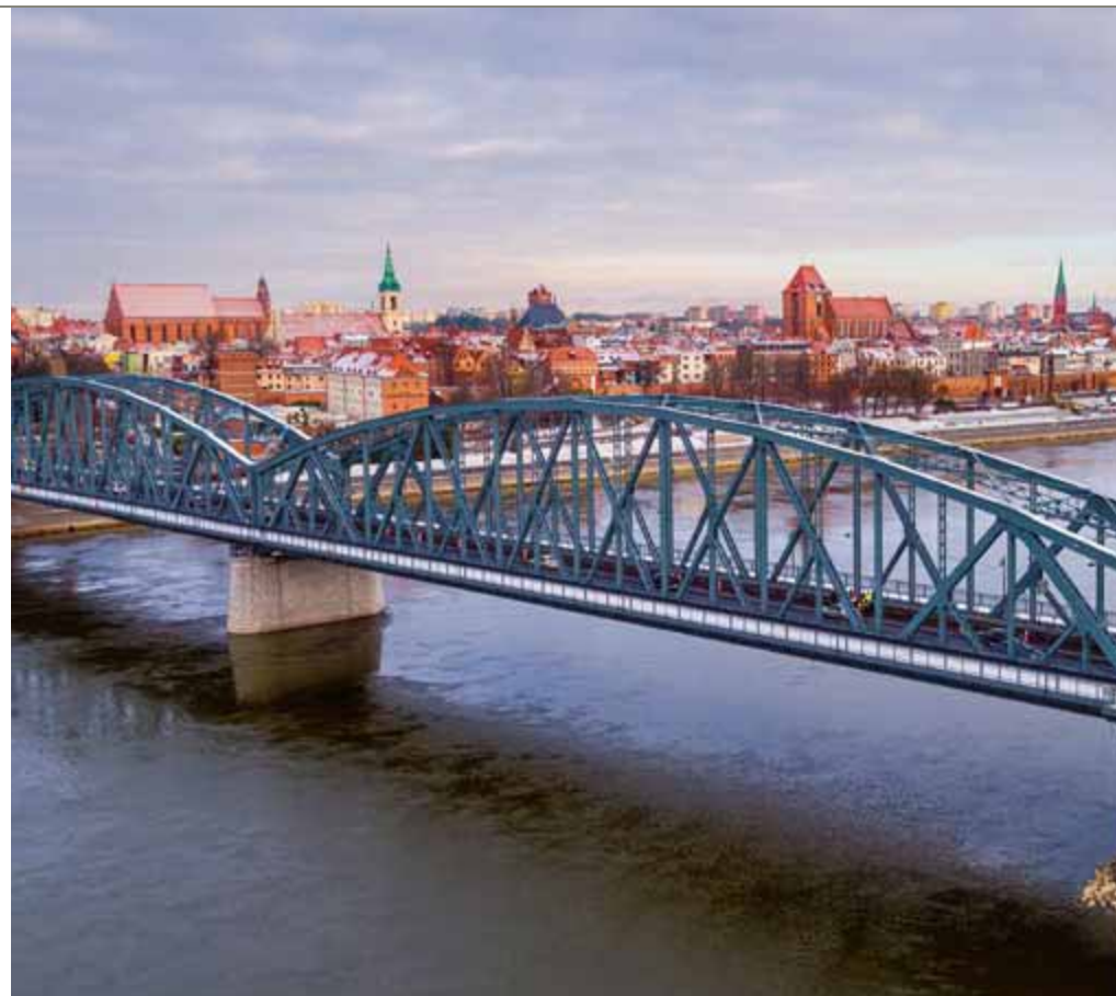
► Zmodernizowany most drogowy im. J. Piłsudskiego w Toruniu
