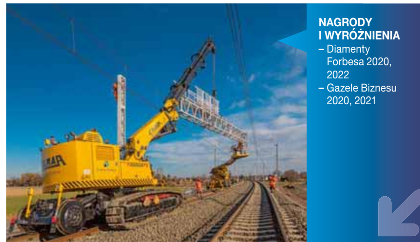
► Montaż bramki semaforowej z użyciem żurawia Colmar
